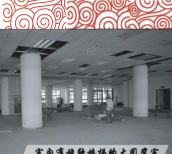
室内有旋转楼梯的大阅览室
