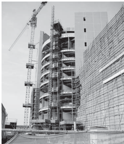
正在建设中的新图书馆大楼 陈拯/摄
